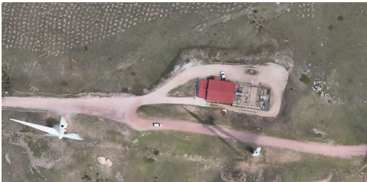
Imagen 10. Planta de la ST El Tablado 45/30 kV.
